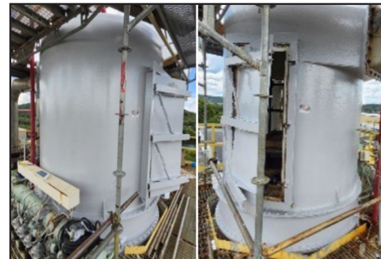
ARC CS2 を CFW-CR で修理した上にトップコートとして塗布。
